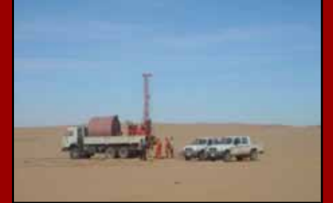
TEKFEN TML JV - LİBYA Great Man Made River Kufra Tazerbo Conveyance Pipeline Geoteknik - Sismik Araştırması 2007 393 km lik yeni boru hattı güzergahın geoteknik, kazılabilirlik ve dewatering yönünden incelemesi.
