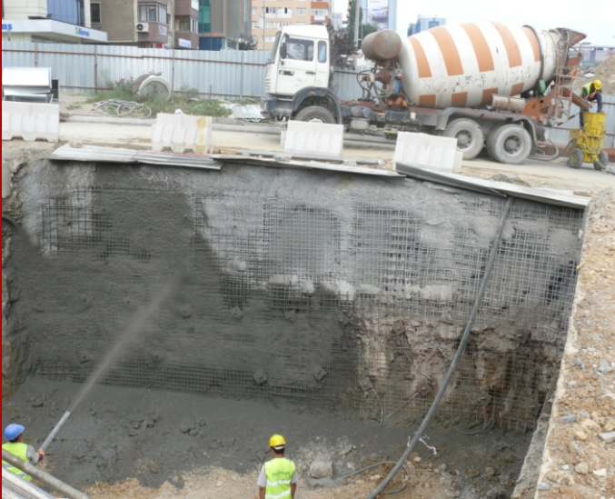
Avrasya Metro Grubu - Geoteknik Yeni Sahra İstasyonu Ankraj ve Zemin Çivisi İmalatları
