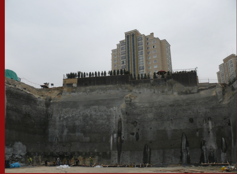
TEKNİK YAPI Bahçeşehir Sosyal Tesis Alanı Püskürtme Beton ve Pasif Ankrajlı İksa İmalatı
