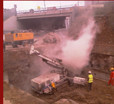
Avrasya Metro Grubu - Geoteknik Yeni Sahra İstasyonu Ankraj ve Zemin Çivisi İmalatları
