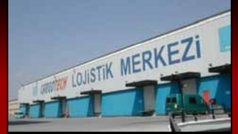
TNT - Cargotech Lojistik Depoları Kıraç - İstanbul, Yapı Deprem Etüdü ve Statik Analizi 2002
