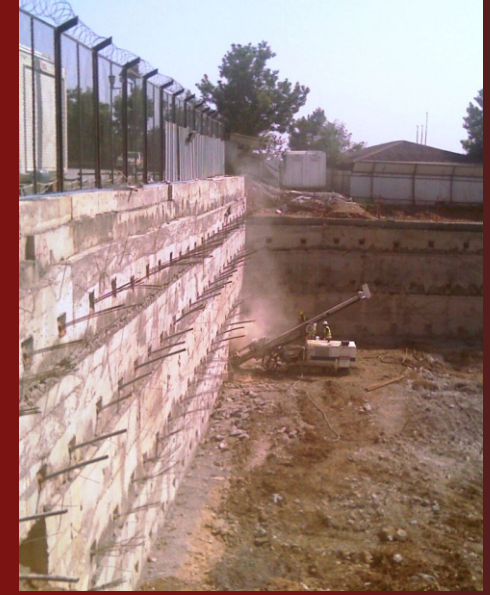
Avrasya Metro Grubu - Geoteknik Cevizli Hastane Yaklaşım Yolu Ankraj ve Zemin Çivisi İmalatları
