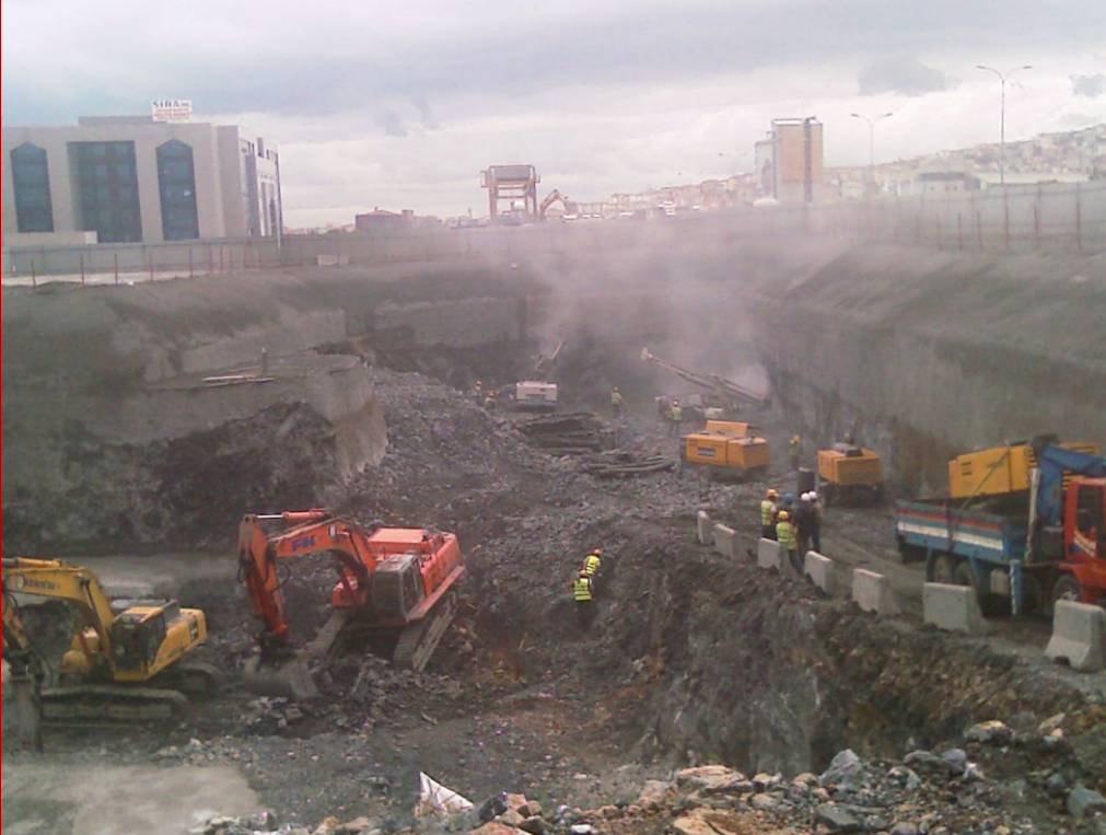
Avrasya Metro Grubu - Geoteknik Kartal Adliye İstasyonu Ankraj ve Zemin Çivisi
